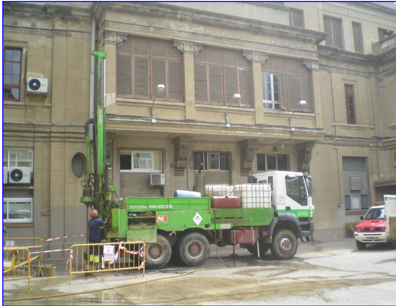
Figura 2: Realització del sondeig a rotació S-6R.
